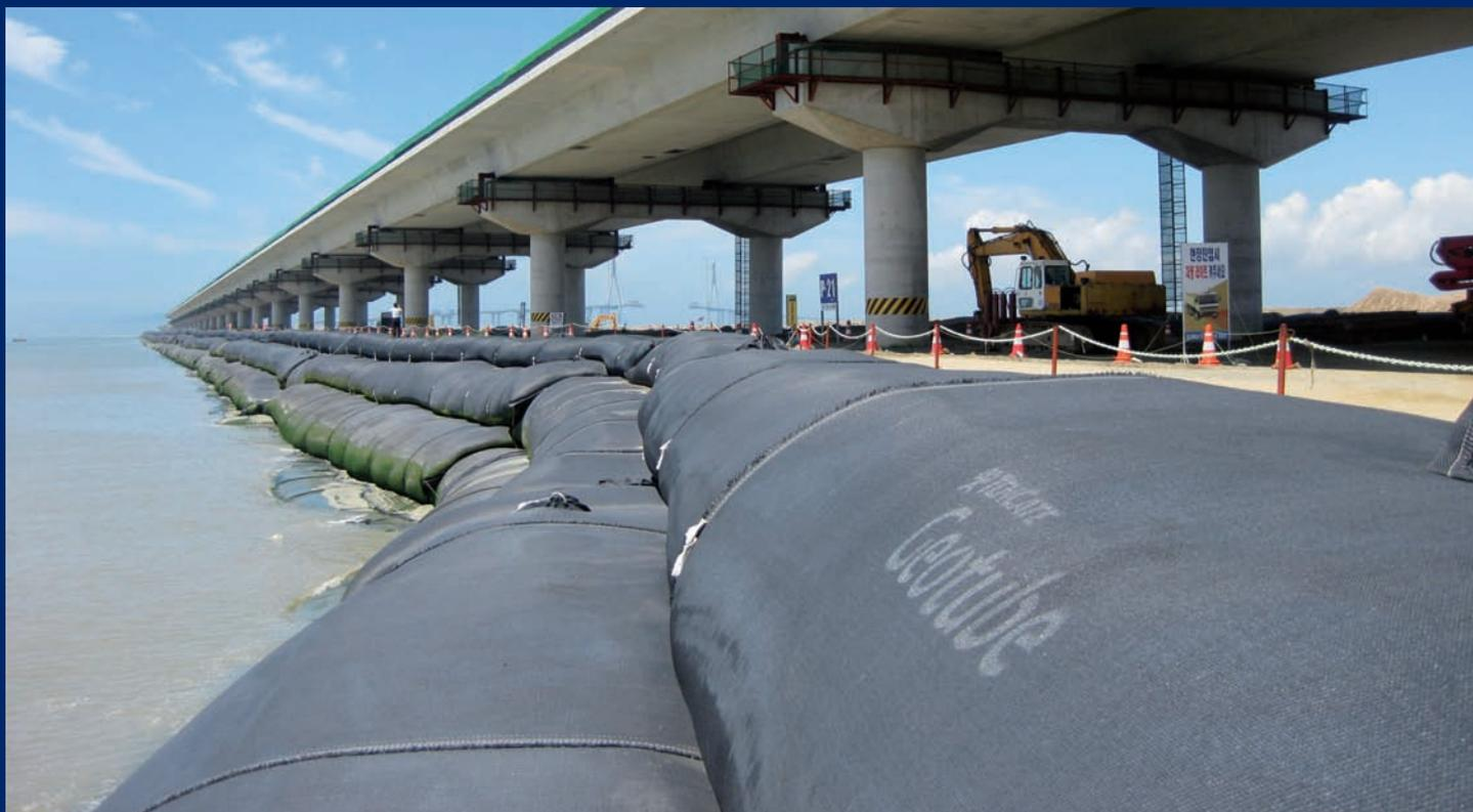
Ouvrage de référence, la construction d'un des ponts les plus long du monde entre Séoul et l'île d'Incheon en Corée du Sud a nécessité l'utilisation d'unités **TenCate Geotube®** afin de réaliser la plate-forme de travail temporaire à sec, indispensable pour l'installation des nombreux pieux de fondation directement dans la mer.
